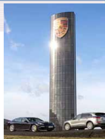
Der Photovoltaik-Pylon ist eine 25 Meter hohe und 37 Tonnen schwere Stahlkonstruktion. Foto: Porsche
